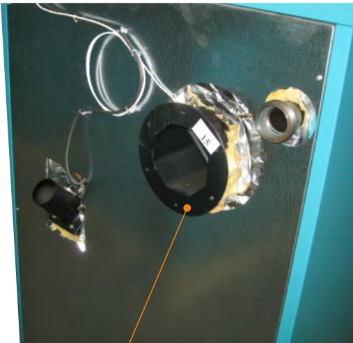
Prirubnica za montažu ventilatora
